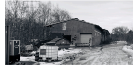
Bahnhofsgelände Ockendorf/Wattenscheid. Der Güterschuppen diente dem Warenumschlag von der Eisenbahn in den Nahtransport durch Pferdegespanne und durch die ersten Lastkraftwagen. Im Umfeld brockelten sich mittelständische Betriebe an. Die Zeichner hatten eigene Gleiszeichnungen. Foto: Archiv des Verfassers
